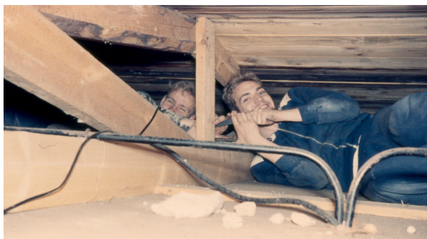
Der var ikke meget plads til arbejdet med isoleringen.
