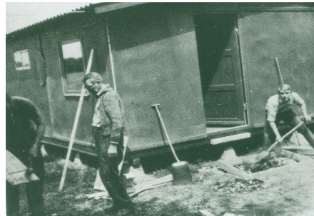
Sølvbryllupshuset under opførelse.
